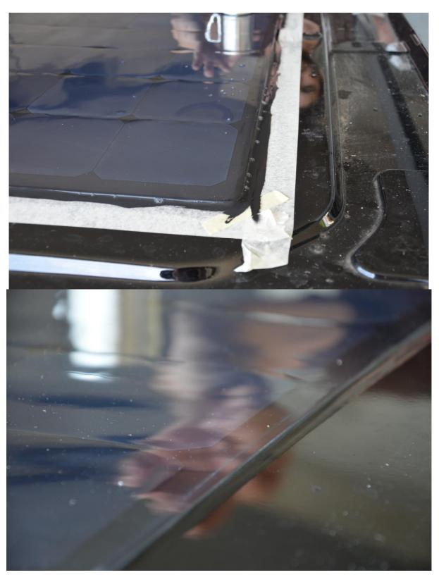
Anschiessend beschweren Sie das Panel mit beliebigen Gewichten und lassen den Kleber rund 24 Stunden trocknen. Grosse Temperaturschwankungen sind während der Trocknungszeit zu vermeiden.
